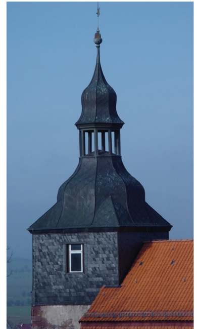
Westturm 25 m hoch mit welscher Haube
