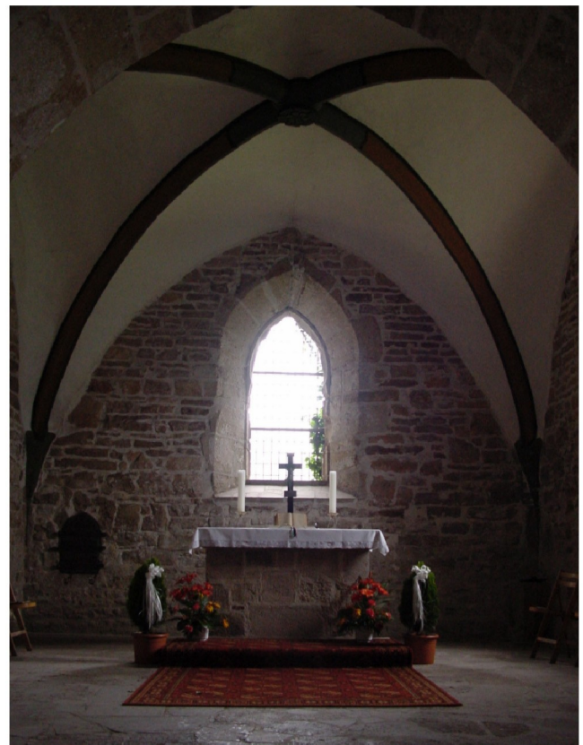
Chor mit spitzbogigem Triumphbogen und Kreuzrippengewölbe
