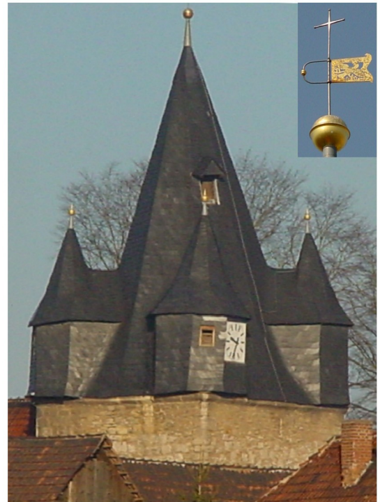
Ostchorturm 20 m hoch mit oktagonalem Turmdach und 4 Nebenhelme
