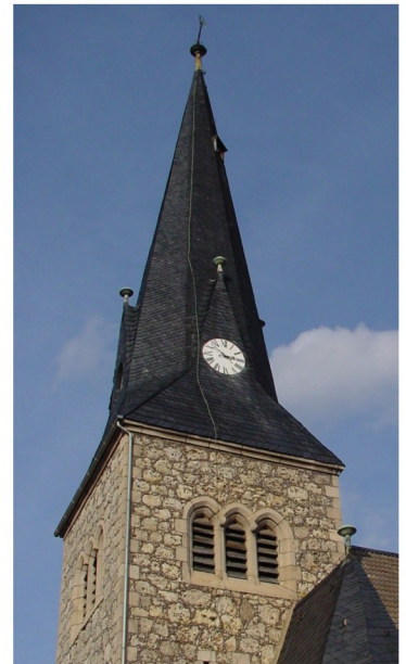
Westturm 43 m hoch mit okt. Turmdach
