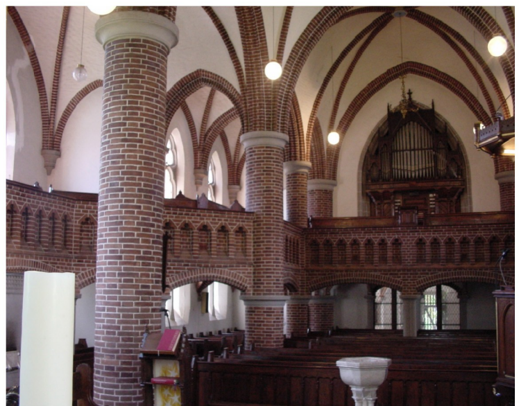
Gemauerte Emporen auf der Süd- und Westseite
