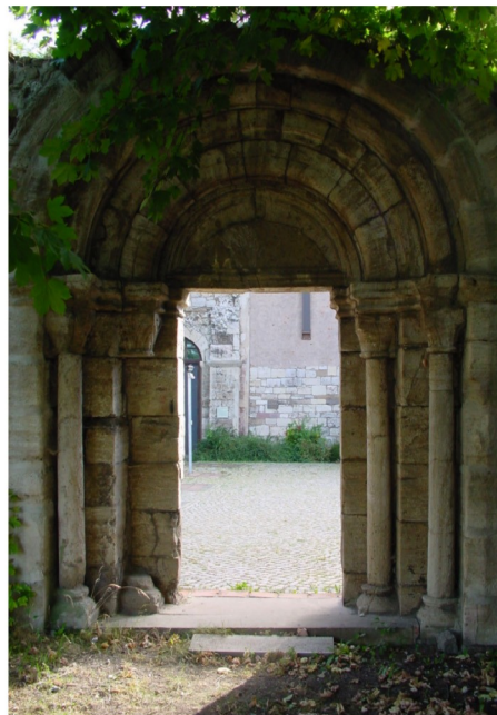
Freistehendes ehemaliges Hauptportal
