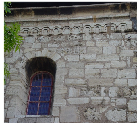
Über dem Fenster Rundbogenfries
