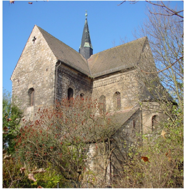
Kirchenansicht von Südosten
