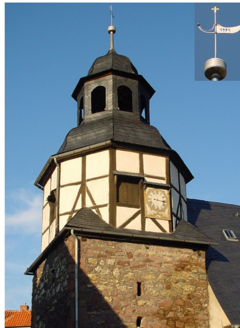
Westturm 22 m hoch mit welscher Haube
