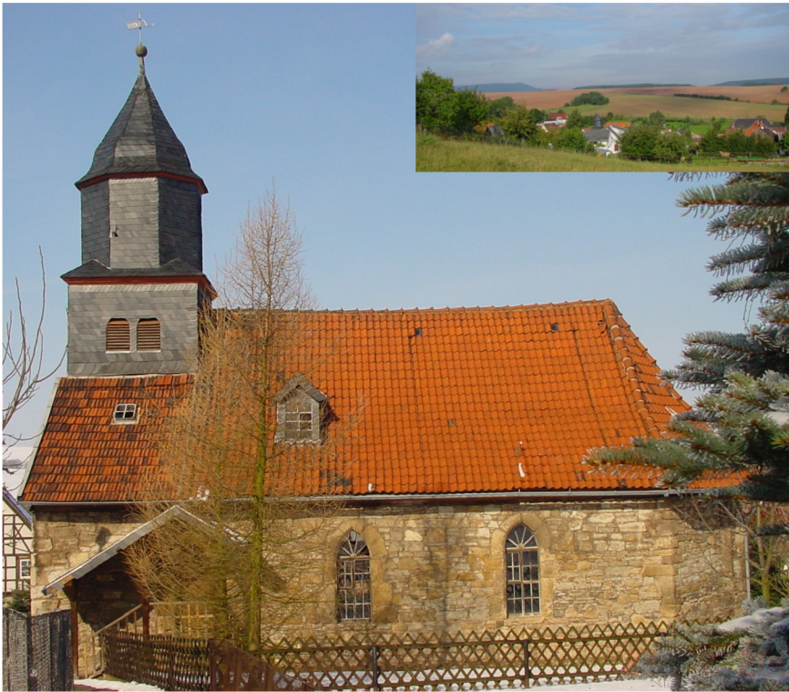
Kirchenansicht von Süden, darüber Ortsansicht von Südosten
