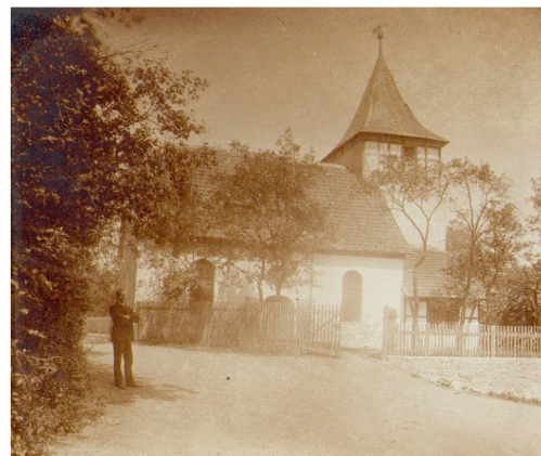
Kirchenansicht von Südwesten vor 1930 (Foto aus Kirche)
