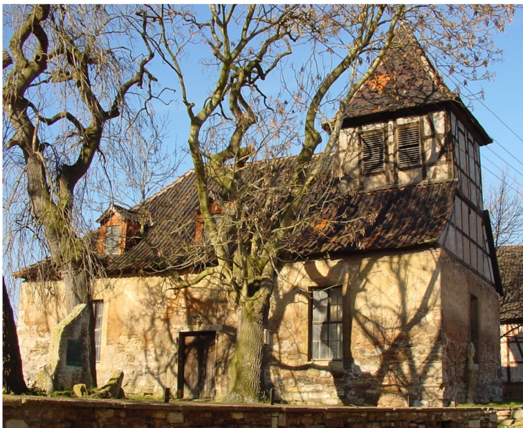
Kirchenansicht von Südosten
