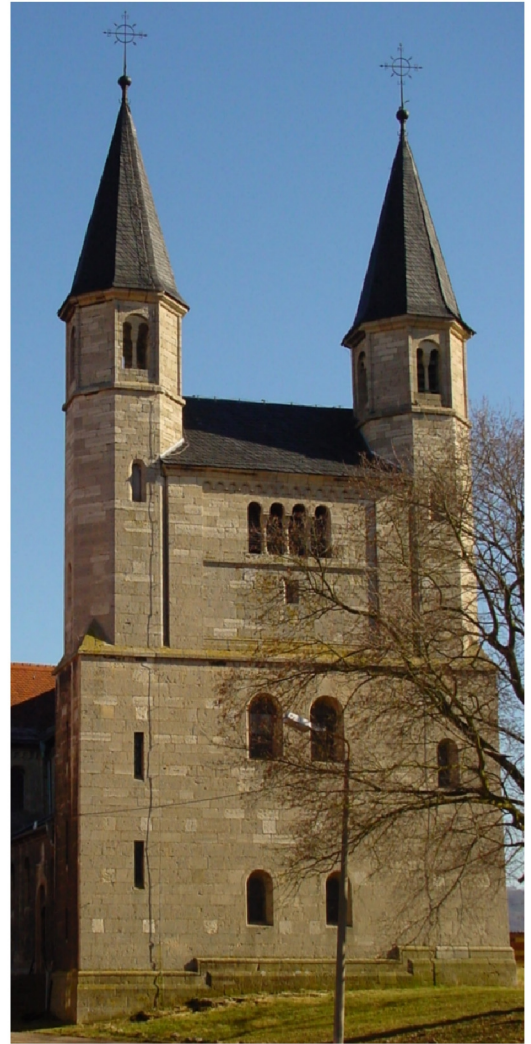
Zwei Westtürme 31 m hoch mit oktog. Turmdach
