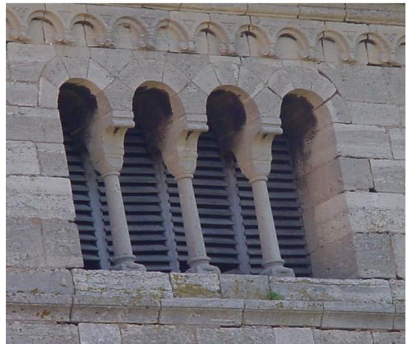
Fenster auf Westseite des Verbindungsbauwerkes der Türme, darüber Bogenfries
