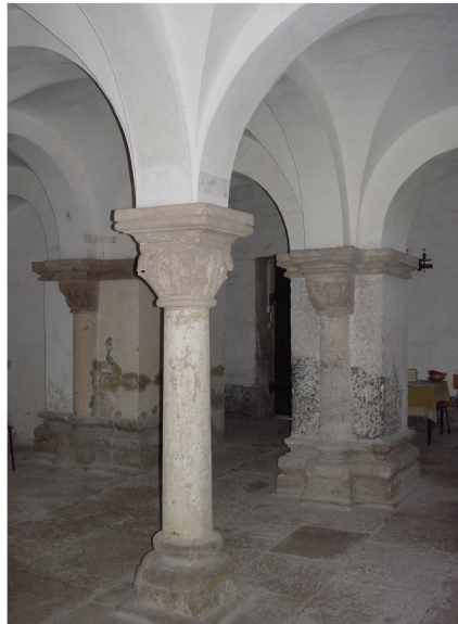
Westliche Vorhalle mit Säule und Pfeiler
