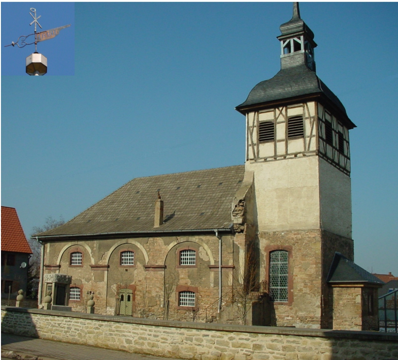
Kirchenansicht von Südosten
