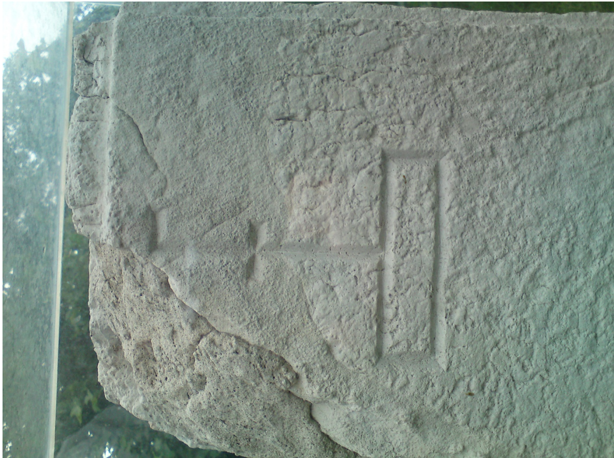
Abb. 31: Das stilisierte trigonometrische Signal ist noch auf dem Quader erkennbar. Eigene Sammlung.
