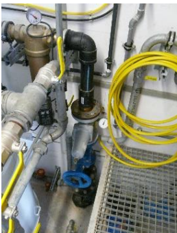
Abb. 9: Blick ins bis 2019 betriebene Wasserwerk Düna, Rehagen.
