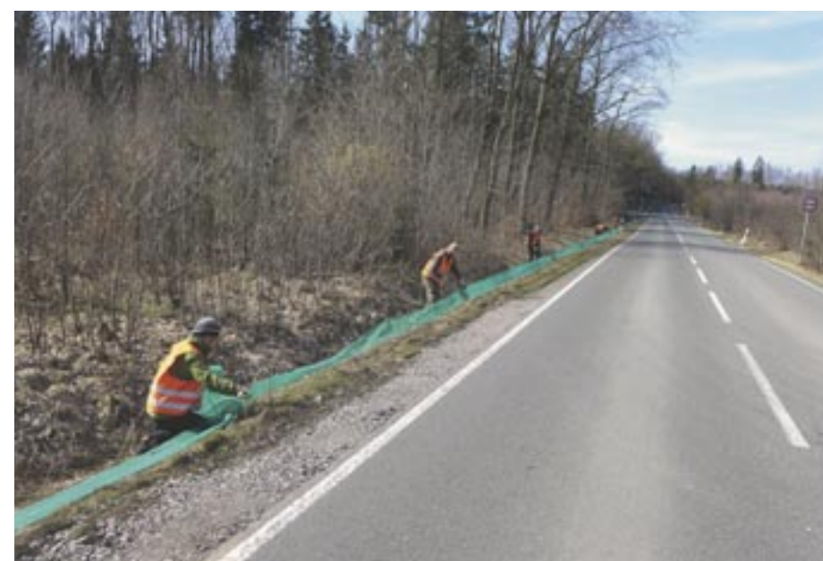
Mitarbeiter des Biosphärenreservates errichten einen Amphibienschutzzaun am Treuen Nachbarsteich bei Hayn.
